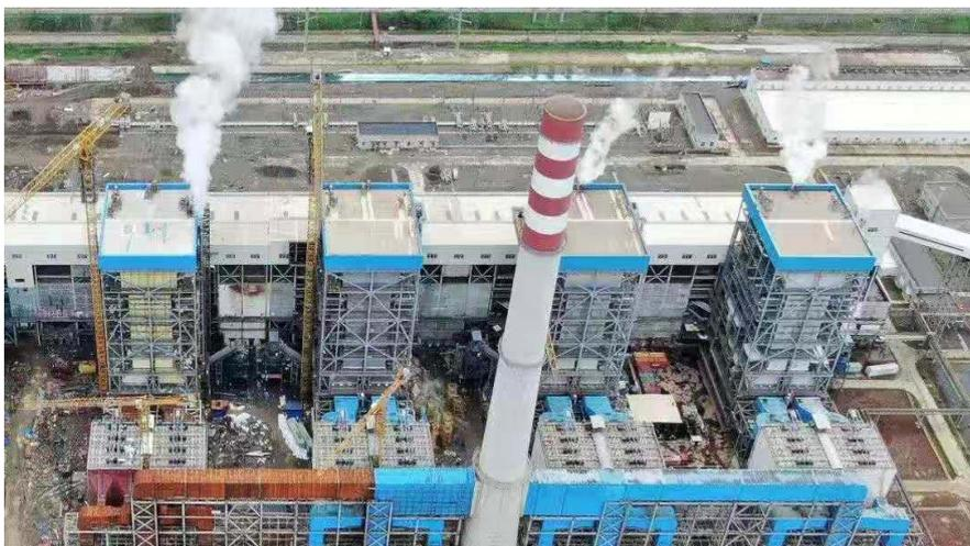
6月1日8时30分锅炉点火；16时40分汽轮机开始升速暖机；19时30分，汽轮机转速平稳升至3000转/分钟，各项性能指标检查良好。经过发电机短路试验、发变组空载试验、零起升压、假同期等一系列试验后，一次并网成功。
